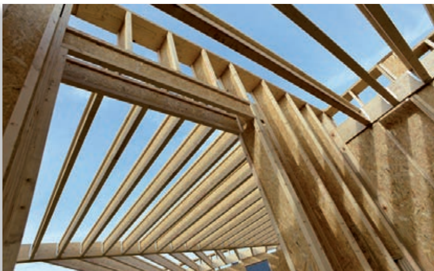
Mur et solivage en poutres en I
